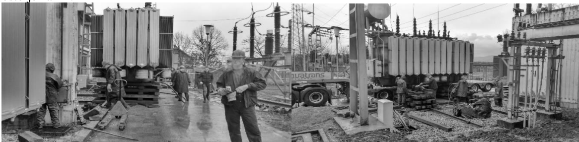
SLIKA 6 – UTOVAR ENERGETSKOG TRANSFORMATORA
