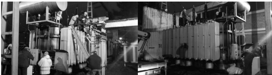
SLIKA 5 – DEMONTAŽA ENERGETSKOG TRANSFORMATORA
